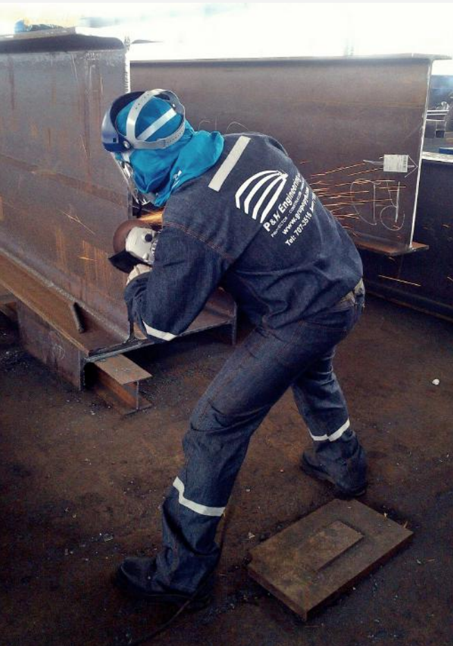
PROYECTO Fabricación de sistemas de moldeo en Fundición Chilca S.A.
